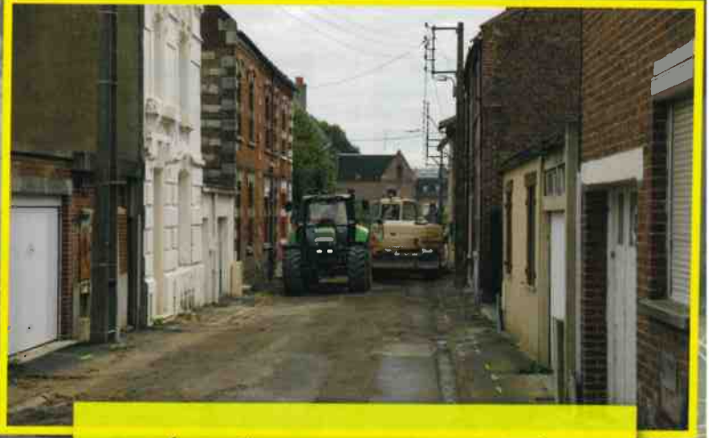
La rénovation des rues du 11 Novembre et Gambetta était l'un des grands projets de la municipalité.
